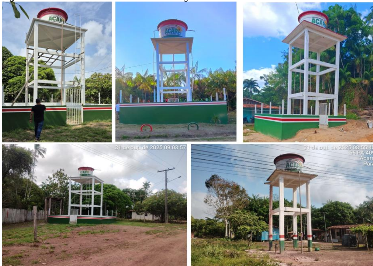
Figura 37- Microssistema de abastecimento de água rural
