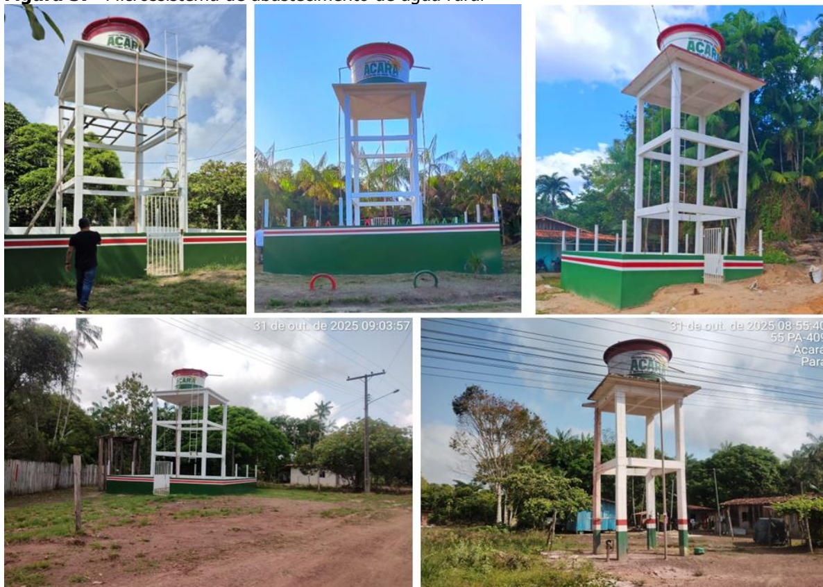
Figura 37- Microssistema de abastecimento de água rural
