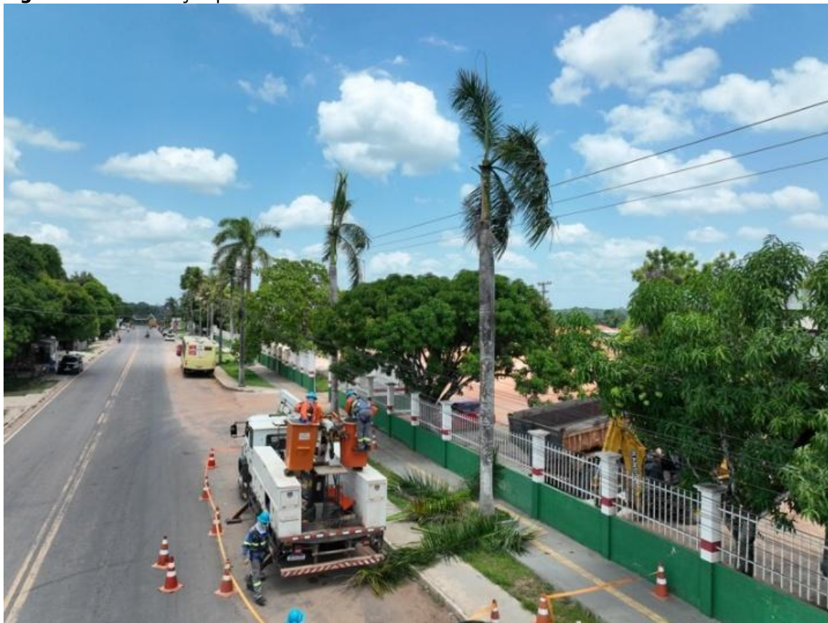
Figura 36- Manutenção periódica da rede da Sede urbana de Acará
